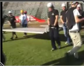
**POSA IN OPERA TRACKWAY** : i pannelli consentono una distribuzione del carico, proteggendo la superficie sottostante da sollecitazioni troppo intense. Ogni pannello viene trasportato dal punto di scarico al punto di montaggio da 6 operatori che impugnano un apposito attrezzo che viene infilato nell'anima cava del pannello.
